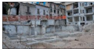
Gli edifici crollati per il terremoto in via Campo di Fossa
